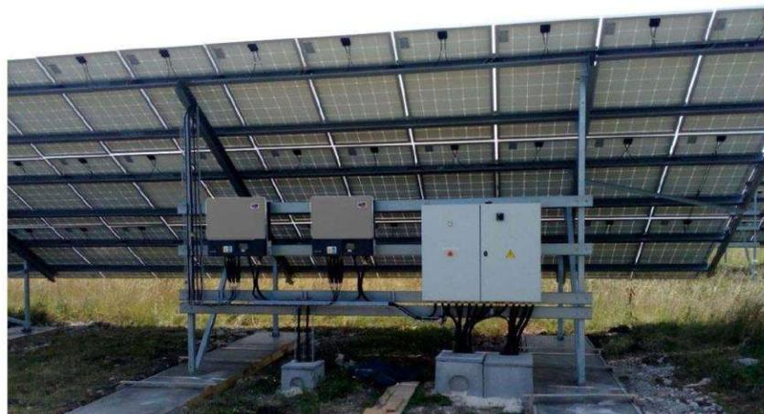
**Figure 13 : Onduleurs photovoltaïques fixés à la structure porteuse des modules**
