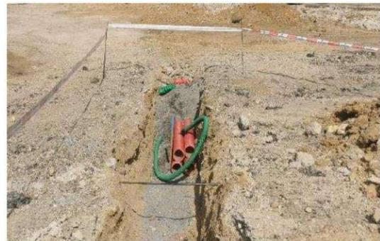
**Figure 12 : Exemple de fourreaux en tranchée**
